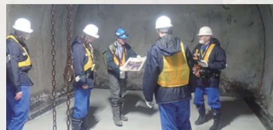
幌延国際共同プロジェクト合同タスク会合での現地確認の様子(2025年12月)
