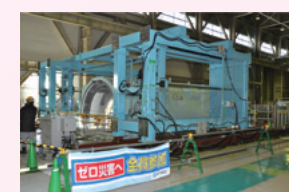
水・蒸気系等発電設備の解体撤去作業
