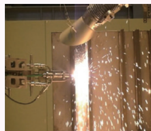
遠隔解体（レーザー切断）
