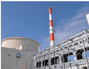
高速実験炉「常陽」
