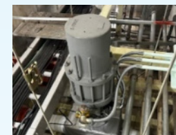
蒸気遮断弁の設置
