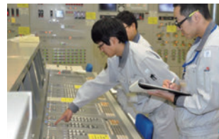
燃料取扱設備操作室の様子
