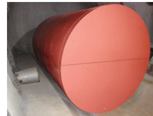
【幌延】坑道構置き模擬PEM ® の設置 ※ Prefabricated Engineered barrier system Moduleの略。鋼製の容器の中に、人工バリアであるオーバーバックや緩衝材を設置し、一体化したものです。
