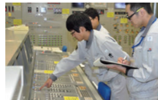
燃料取扱設備操作室の様子
