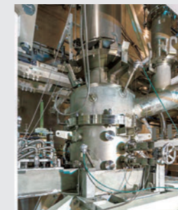
OWTFに設置した焼却溶融設備
