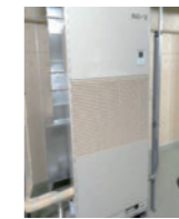
空調設備更新による高効率化
