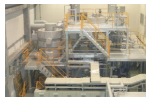
安全技術開発ループ試験設備
