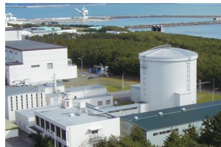
原子炉安全性研究炉(NSRR)
