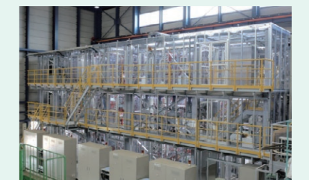
連続水素製造試験装置 水素製造量：～0.1m 3 /h-H 2 、W18.5×D5×H8.1(m)
