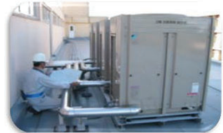
空調機新設工事
