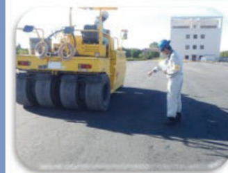
駐車場整備・拡張工事
