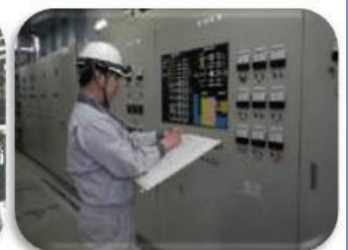
原子力施設の巡視点検
