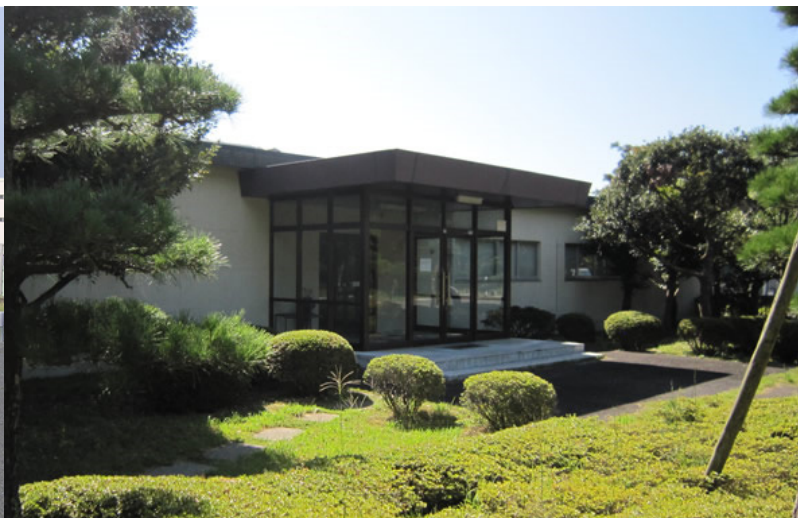
A棟(ウラン系分析・ 試験施設)
