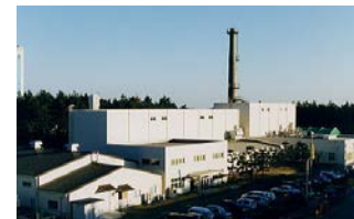
照射材料試験施設 (MMF)
