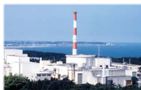
高速実験炉 (常陽)
