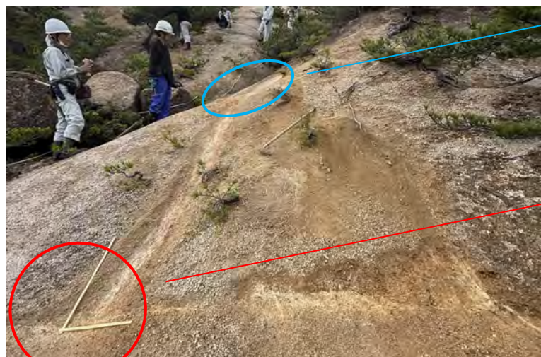
破碎部全景写真（露頭南側）
