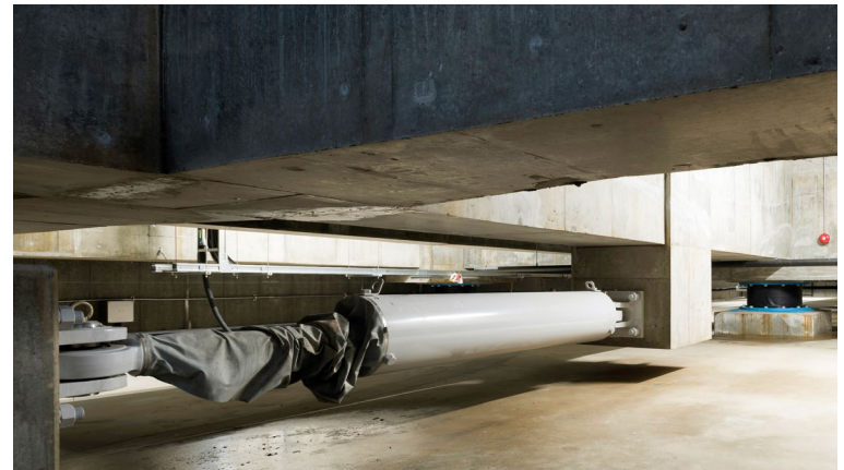
オイルダンパー設置状況
