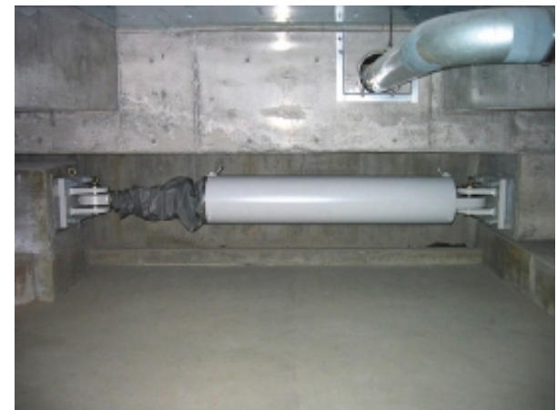
オイルダンパー設置状況
