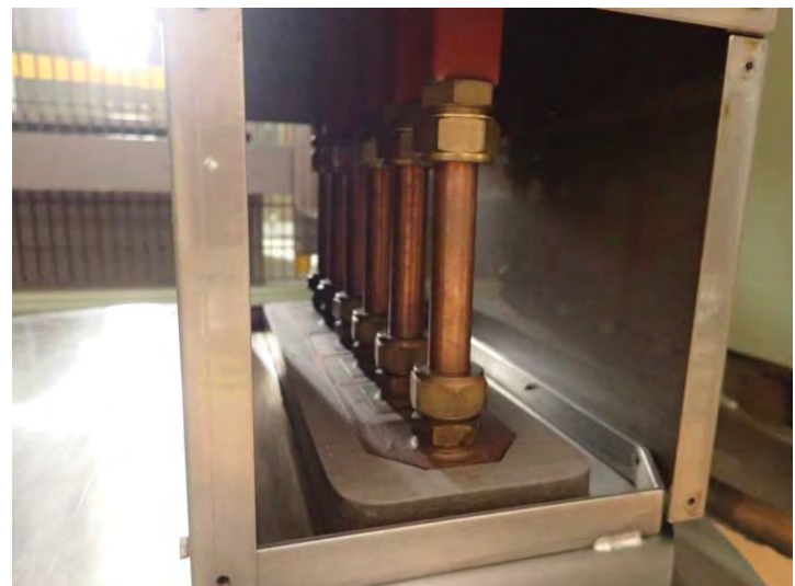
点検箇所④
