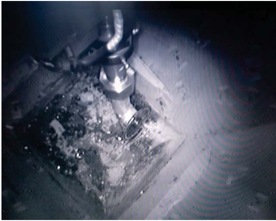
工学試験棟での訓練状況 (7/17)
