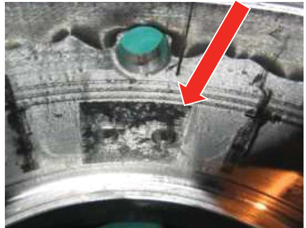
写真 2-2 タービン側弾性装置（外環）
