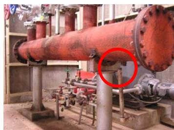
ボイラー配管の破損
