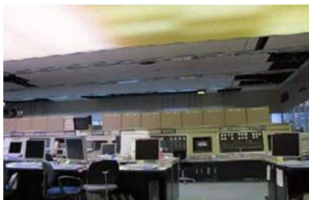
中央制御室の天井板の落下の状況
