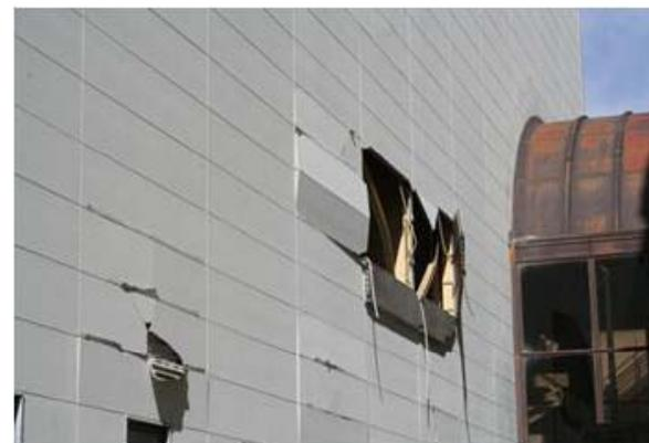
実験準備棟の外壁落下の状況
