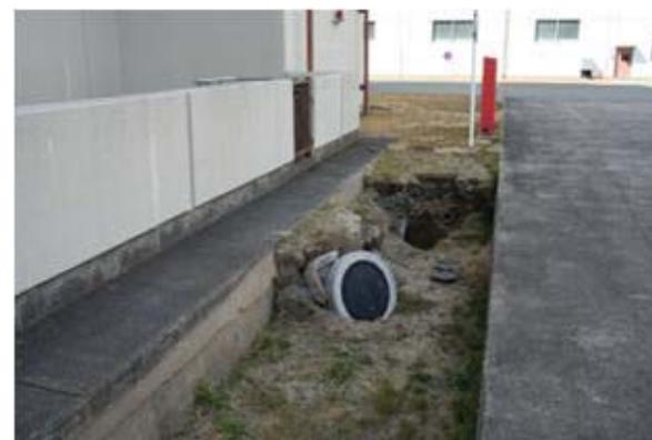
JT-60実験棟廻の地盤沈下の状況
