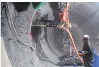
坑道へのセメント吹付け 遠隔施工試験（幌延）
