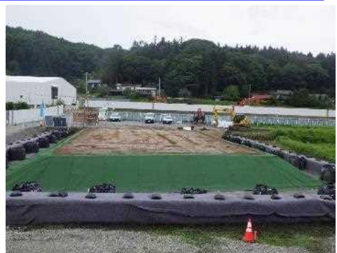
盛土実証ヤード(2019年6月)
