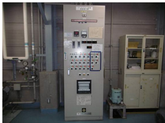
ユーティリティ排水設備
