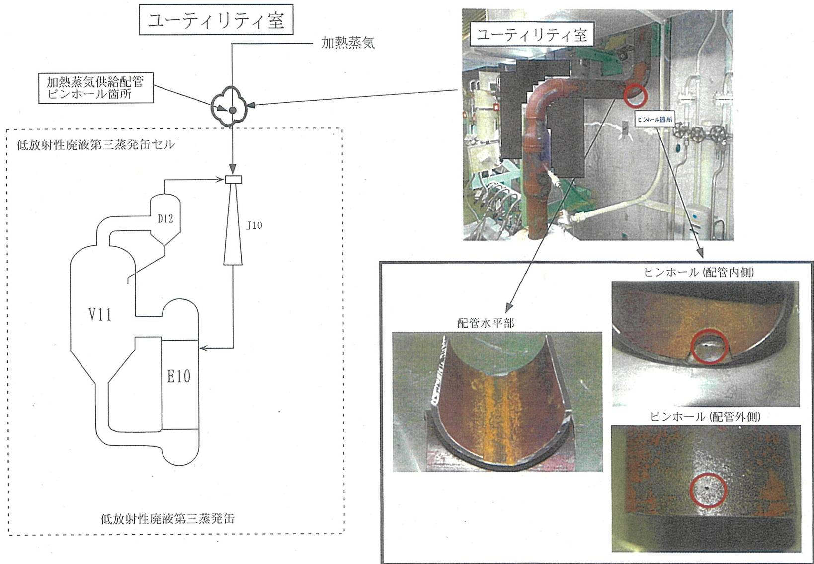
図1 蒸気供給配管ピンホール箇所の概要
