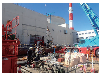
高速実験炉「常陽」新規制基準対応工事の様子 (主冷却機建物の地盤補強工事(地盤改良))
