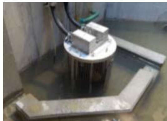
PSFを用いたモニタの設置状況
