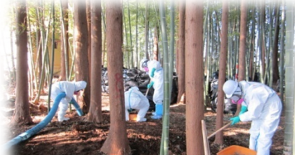
落葉・腐植土層除去(森林)
