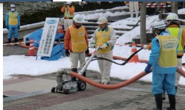
超高圧水洗浄による道路、歩道、駐車場の洗浄(株式会社キクテック)
