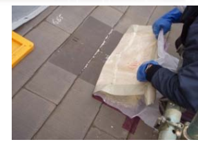
吸塵式サンダーによる学校、公園、大型施設の屋根・屋上の研磨除染(志賀塗装株式会社)
