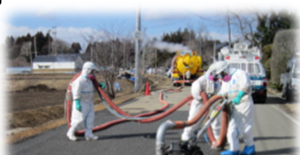
道路・駐車場の洗浄、切削等
