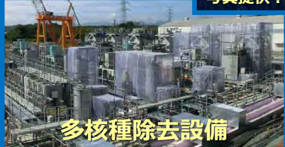
溶接型タンク
