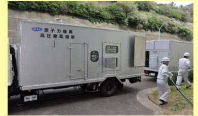
電源車接続訓練
