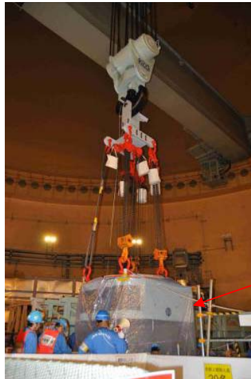
燃料出入孔ドアバルブ撤去作業
