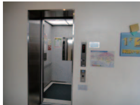
【エレベーター】
