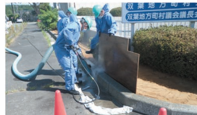
●駐車場での除染作業 汚染物質を含んだ水が流れないようにウエスを利用する方法は、現場作業の中から生まれたノウハウです。
