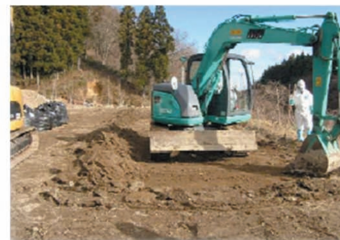
農地の表土の剥ぎ取り
