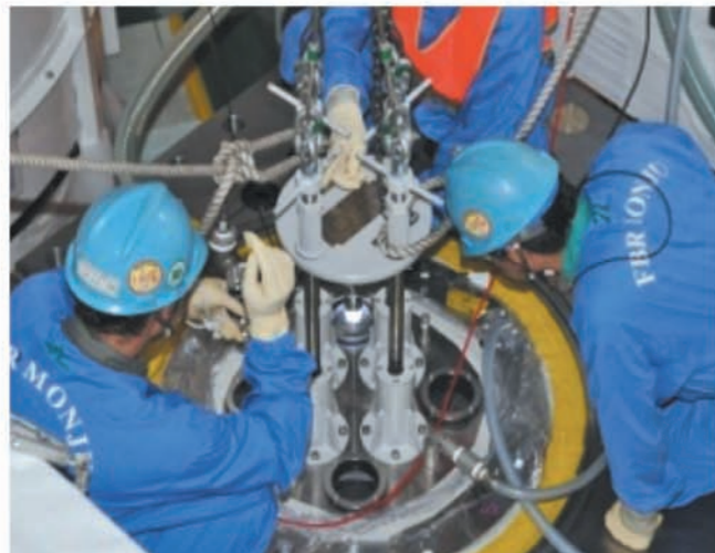
引き抜きに向けた工事の開始(平成23年5月24日)
