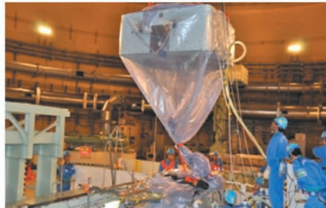
(上) フラバック*を用いて周辺機器(燃料出入孔ドアバルブ)を取り外す作業を実施(5月30日)
