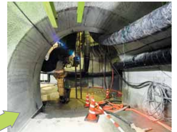
深度250mの換気立坑
