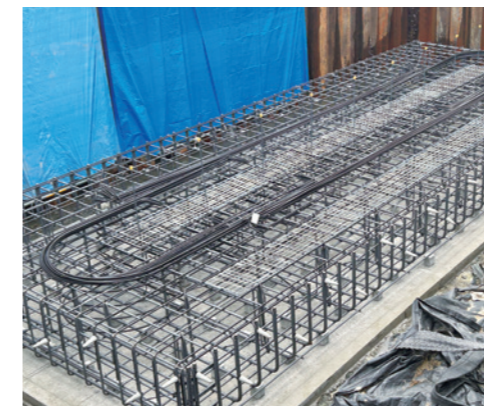
南越前町鯖波大橋(仮称) 新設工事場所(写真提供:福井県)
