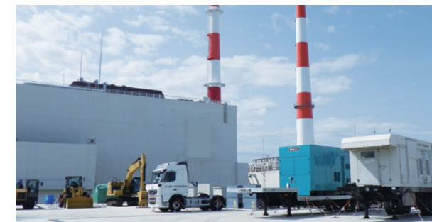
重要な安全機能回復のための資機材整備例(移動式発電機や土砂撤去のための重機類)
