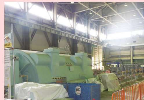
タービン発電機(解体中)
