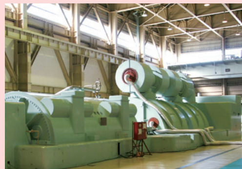
タービン発電機(解体前)
