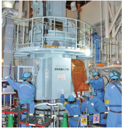
施設定期検査で1次系ナトリウムの主循環ポンプを分解点検し据付作業を行う様子
