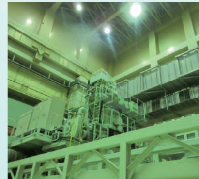
燃料体を移送するときに使う燃料出入機
