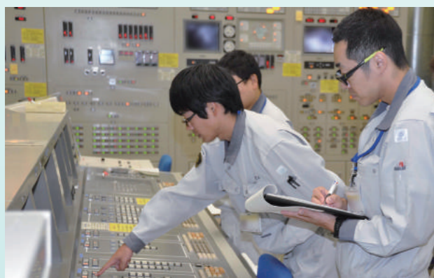
「燃料体取出し作業」中の操作室
