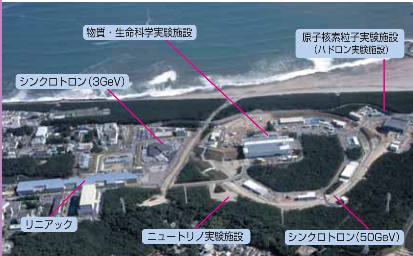
●J-PARC全景/心臓部の50GeVシンクロトロンは、1周約1600m、直径約500m。
