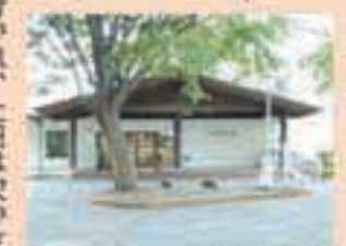
●八戸市武蔵館
