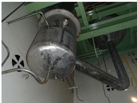
低放射性廃液第二蒸発缶
