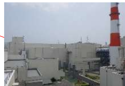
分離精製工場(MP)
