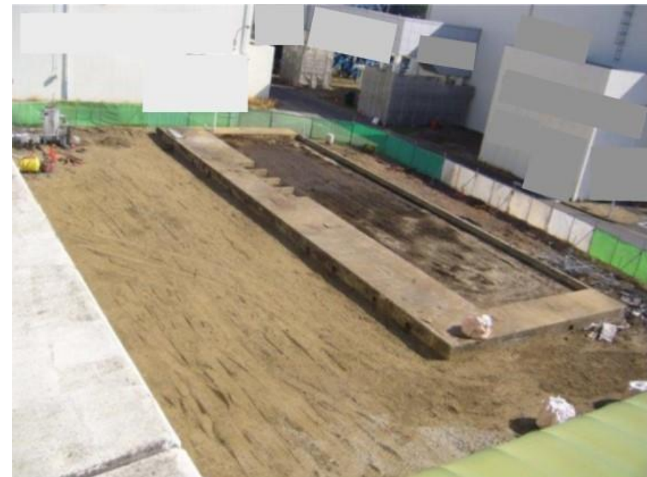
解体撤去工事後
