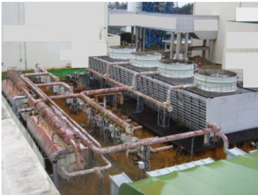
解体撤去工事前
