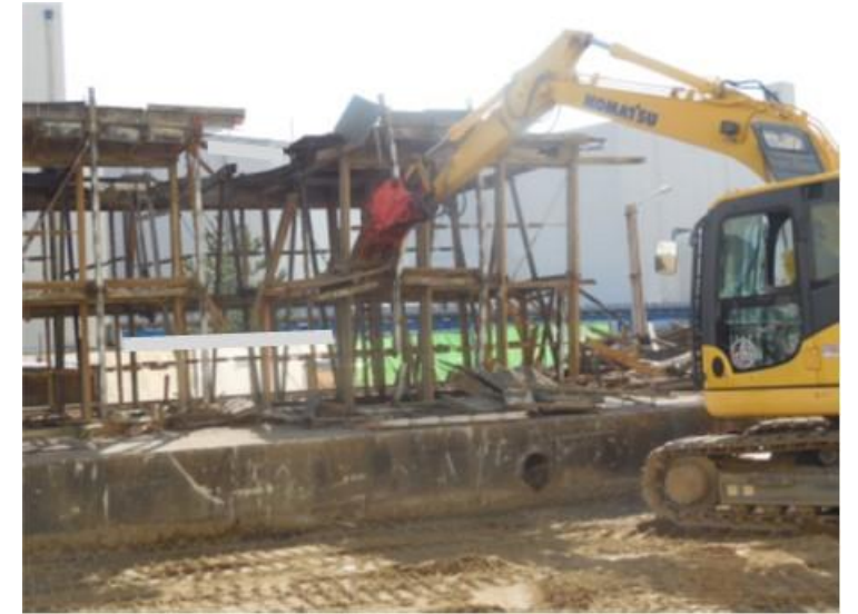
重機を使った解体の様子
