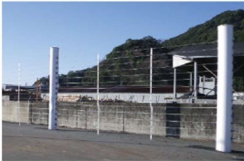
津波漂流物防護柵の設置イメージ
