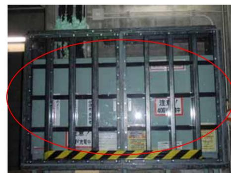
緊急電源接続盤浸水防止対策
