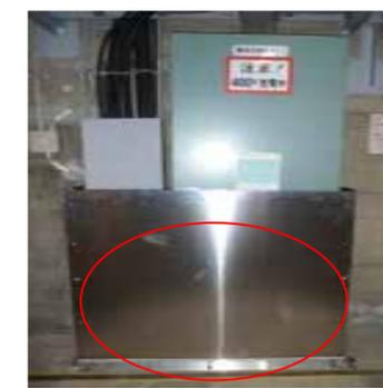
電源切替盤浸水防止対策
