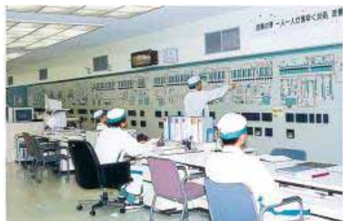
工程監視の様子
