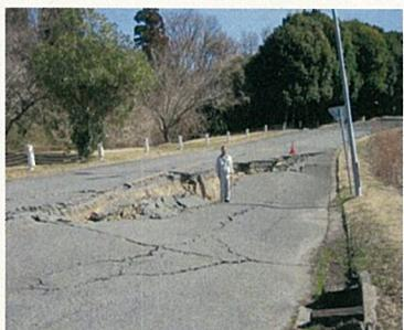
約20mにわたり大きな地割れ、1mの陥没。
