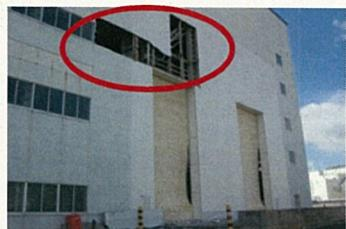
建屋内に設置してある20tクレーンが落下。
