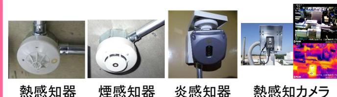
熱感知器 煙感知器 炎感知器 熱感知カメラ
