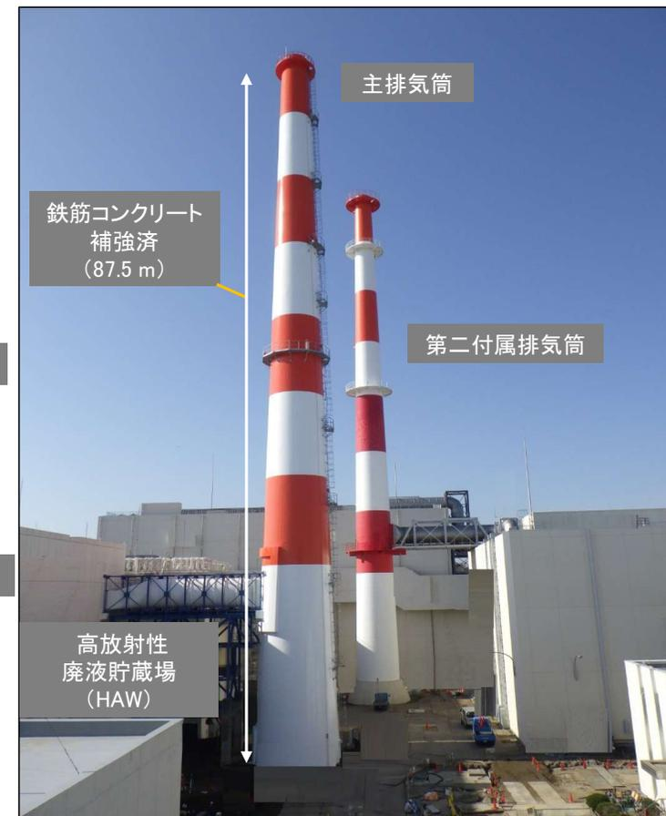
主排気筒の筒身補強工事の状況
