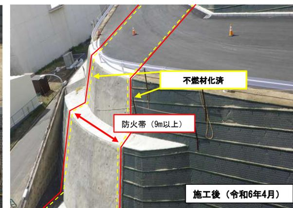
防火帯設置場所の施工状況
