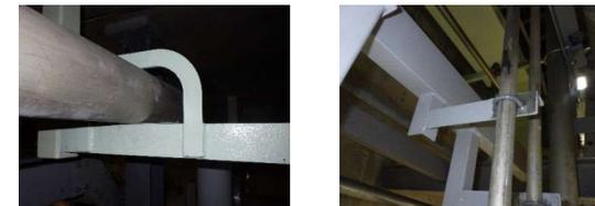
溢水源となる配管の補強例
