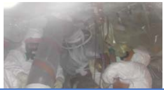
配管を解体しての堆積物除去作業（従来の方法）
