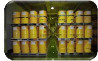
ドラム缶保管状況#
