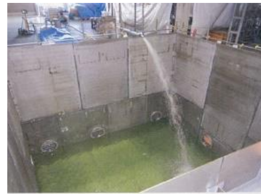
水槽への水張状況
