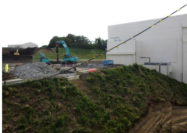
掘削前（令和4年6月）
