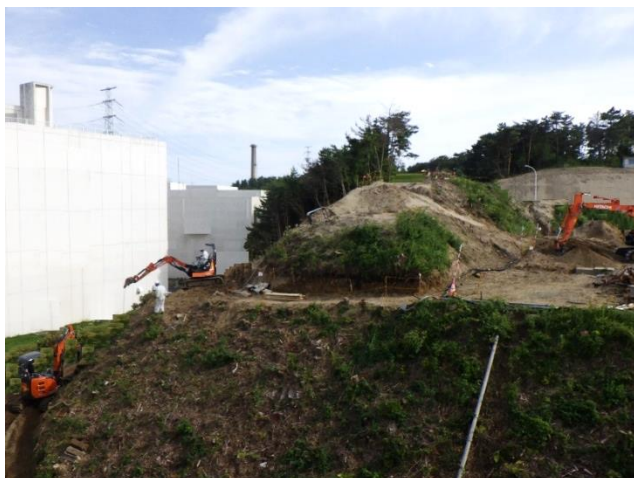
掘削前（令和4年6月）
