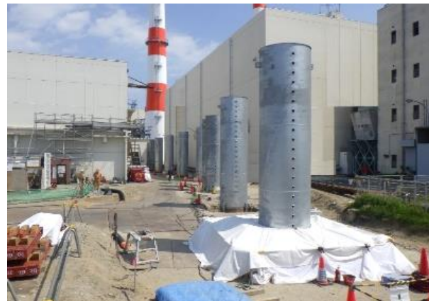
支柱の建込状況(押し波)
