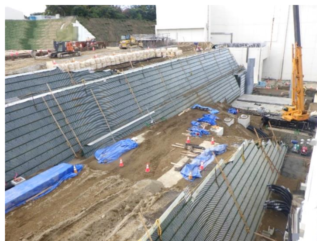
改良土盛土の様子（令和5年11月）
