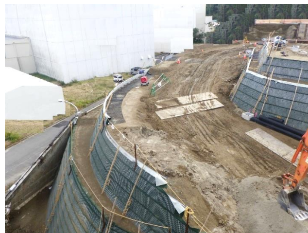
改良土盛土の様子（令和5年11月）
