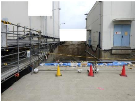
地盤改良状況(押し波)
