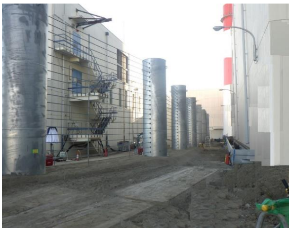
津波防護柵(押し波)の 設置状況(令和5年12月)
