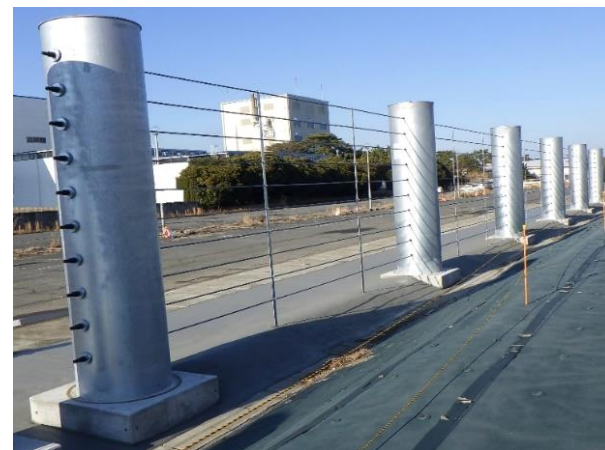
津波漂流物防護柵(引き波)の 設置状況(令和5年1月)
